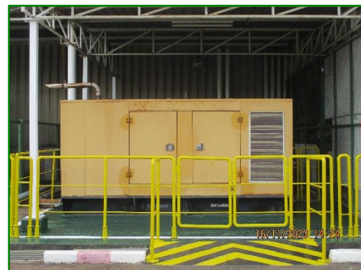
ภาพที่ 2.5 เครื่องกำเนิดไฟฟ้าสำรองที่ใช้น้ำมันดีเซลเป็นเชื้อเพลิง
