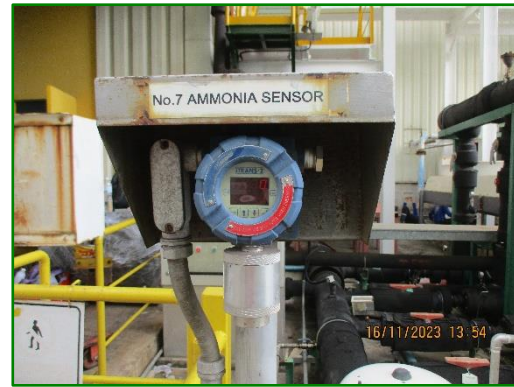
ภาพที่ 2.33 การติดตั้ง Gas Detector ภายในโครงการฯ
