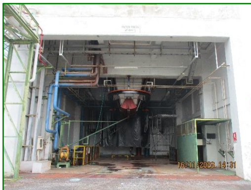
ภาพที่ 2.15 ถังเก็บ (Hopper) สำหรับรวบรวมตะกอนจากระบบบำบัดน้ำเสีย
