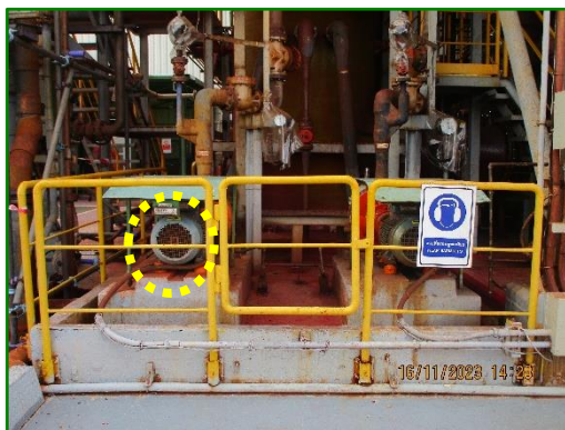
ภาพที่ 2.4 เครื่องสูบน้ำสำหรับไอรกรดของ Scrubber
