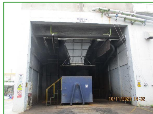
ภาพที่ 2.15 ถังเก็บ (Hopper) สำหรับรวบรวมตะกอนจากระบบบำบัดน้ำเสีย
